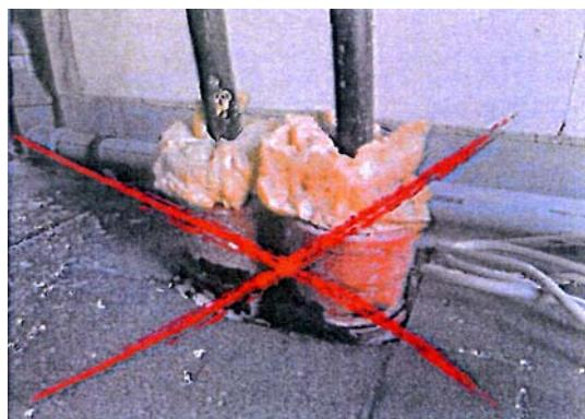
**Der Wassserbeschaffungsverband Büchlberg weist ausdrücklich darauf hin, dass die vielfach verwendeten Einführungshilfen mittels KG- oder HT-Rohre nicht mehr zulässig sind!**
