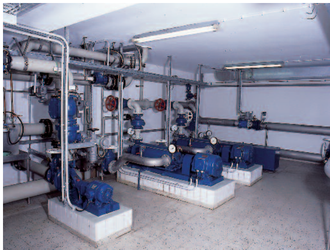
Förderpumpen vom Pumpwerk Gummering zum Hochbehälter
