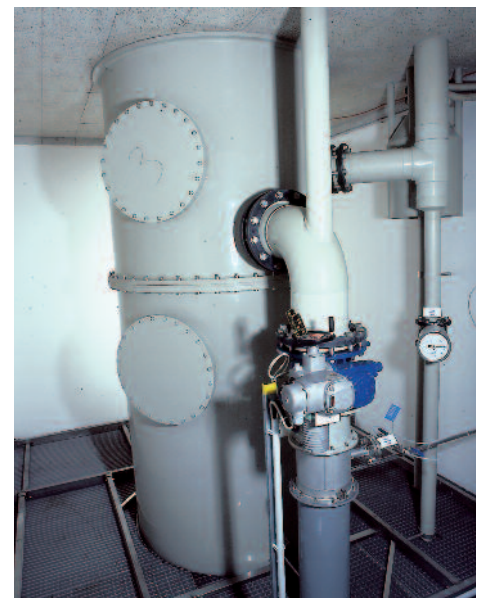
Anlage 1: Riesler (Entsäuerung Kohlensäure ca. 95 %)
