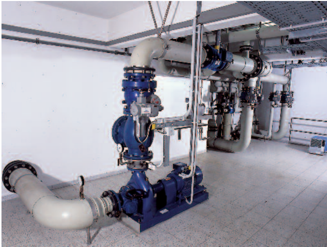
Anlage 2: m Spülwasserpumpe im Rohrkeller
