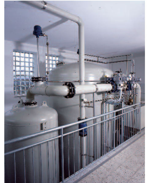
Anlage 1: Oxidator und Filterkessel B
