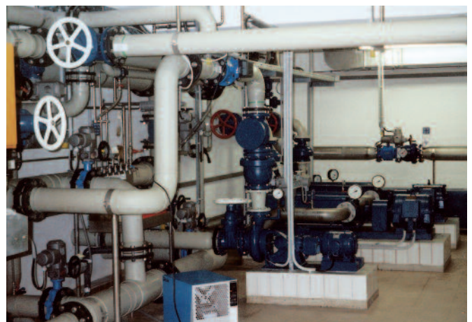
Hochdruckpumpen zur Wasserförderung in die Hochbehälter
