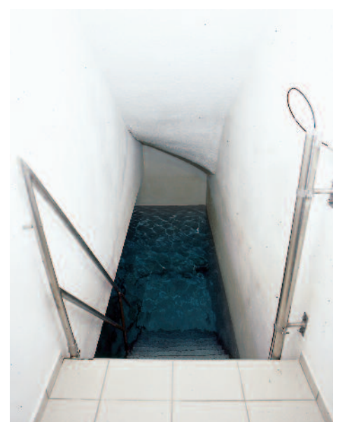
Anlage 2: Saugbehälter (Inhalt 85 m³)
